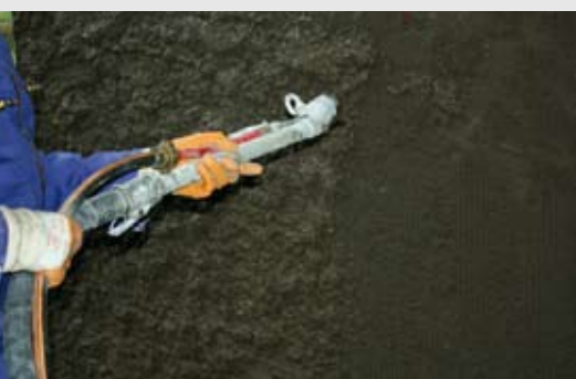
Drainputz Spritzverfahren
