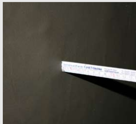
Drainputz 40 mm in einem Arbeitsgang aufgetragen
