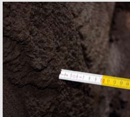
Drainputz 30 mm in einem Arbeitsgang aufgetragen
