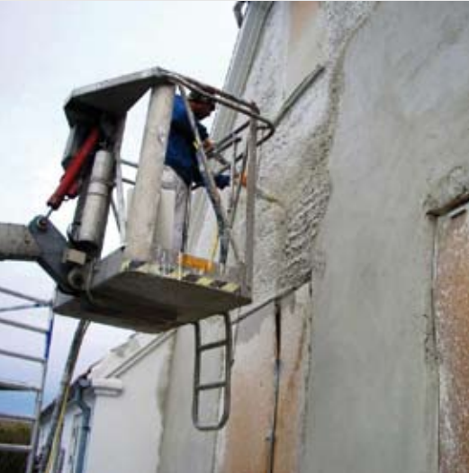
Drainputzauftrag mit Putzmaschine
