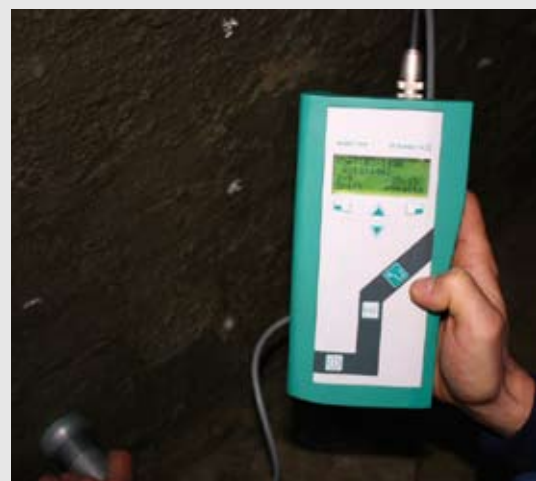
Feuchtigkeit im Mauerwerk (Messung)
